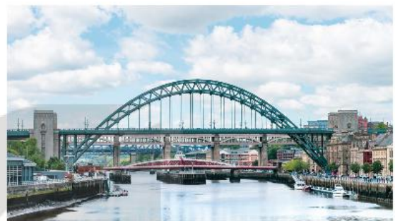
Hình 3.17. Cầu Tyne ở Anh với thiết kế có cung parabol
